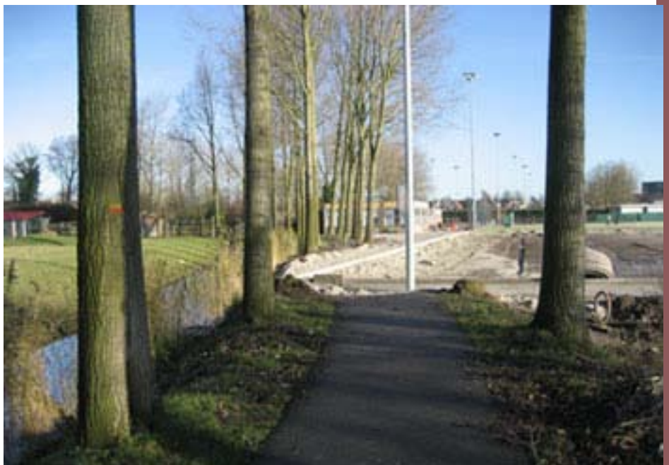
Aanleg kunstgrasveld door Grote Bospad
