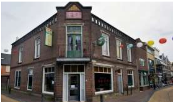
Keizerstraat 1 – voormalig Chinees Restaurant Man Foe met karakteristieke gevel 1
