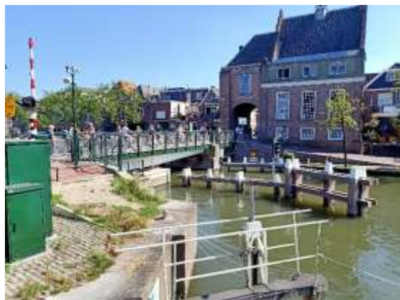
De gerenoveerde IJsselbrug.
